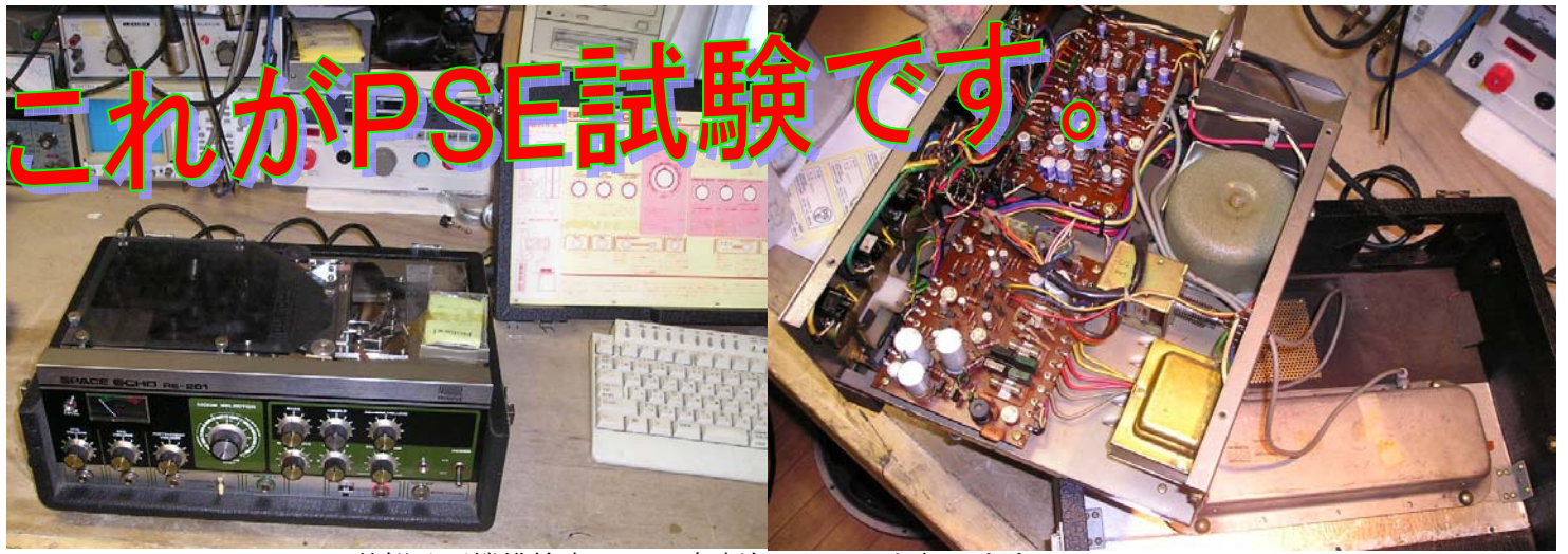
外観及び機構検査、この時洗浄のメンテも行います。
